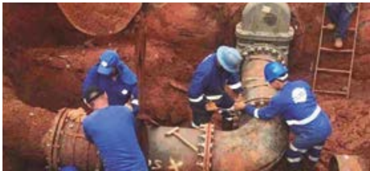
São feitas interligações e instalação de hidrantes, válvulas de descarga e redutoras de pressão nas redes de distribuição de água em várias regiões
